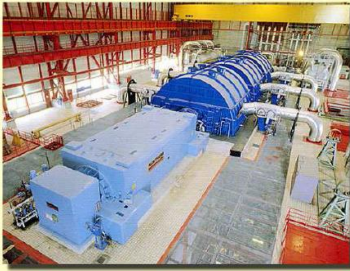
Exemple d'alternateur de forte puissance 1300 MW - 1500 t/min - 50 Hz triphasé
