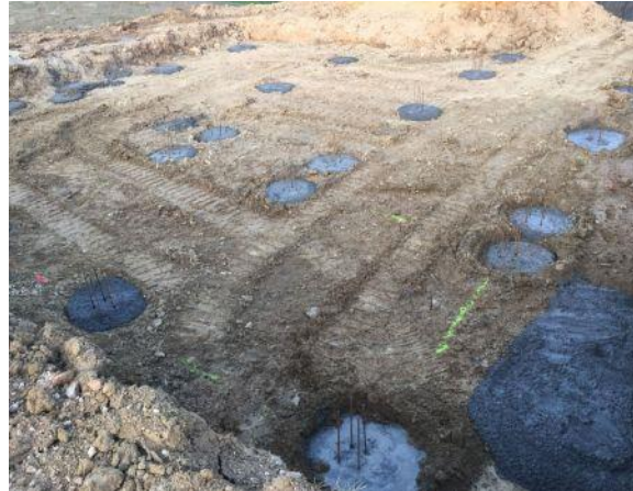
Figure 4.3. Fondation profonde.
