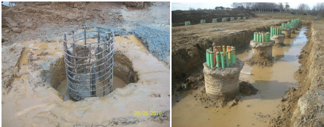
Figure 4.1. Tête du pieu après le coulage du béton. Figure 4.2. Pieux de piles de pont.
