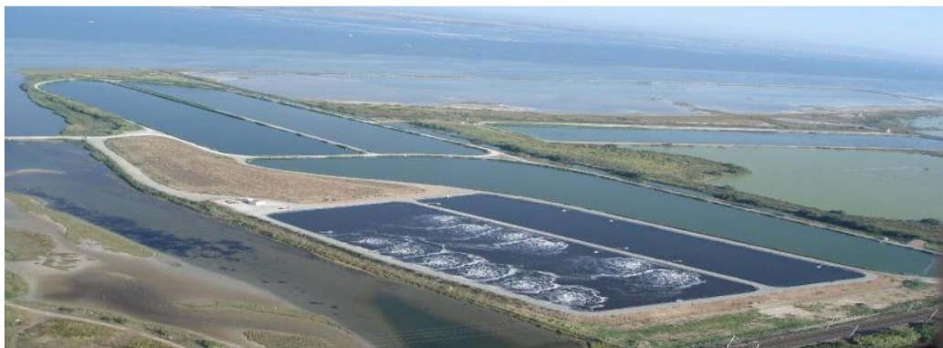
Figure 4: Photo de bassins de lagunage aéré.
