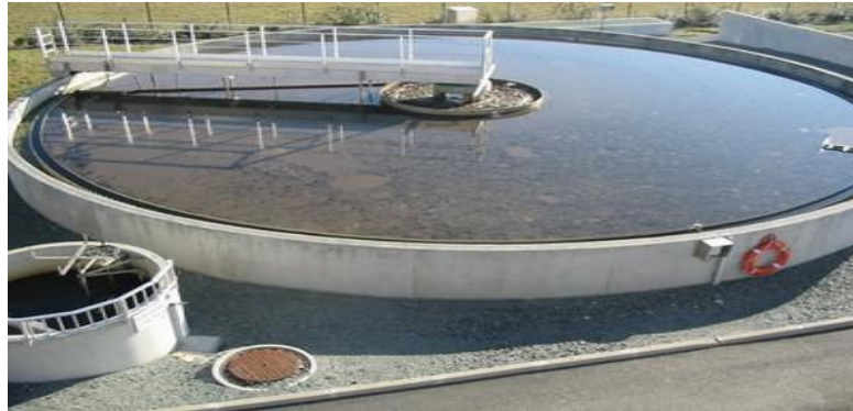
- Bassin de décantation
