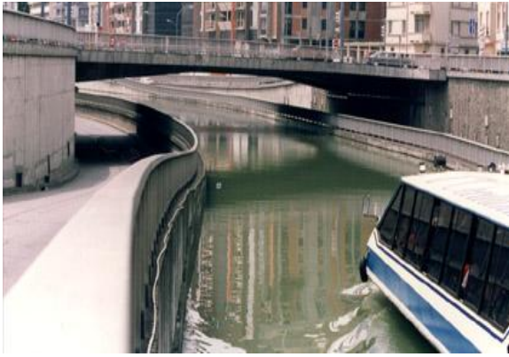
Stabilisation par mur en béton
