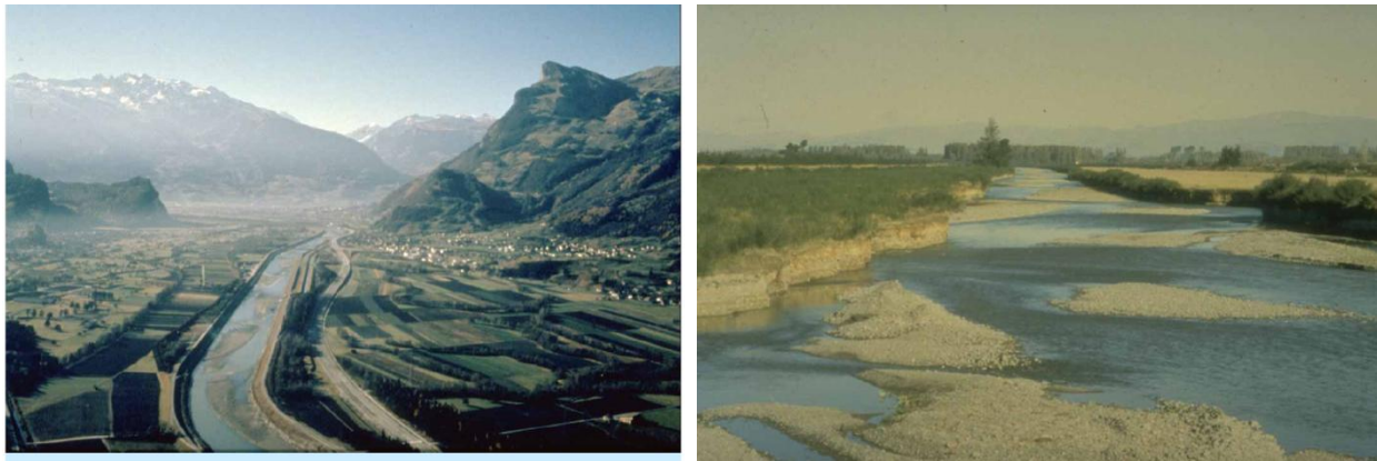
Figure 6.10. Formation de bancs dans le cours d'eau (EPFL.....)
