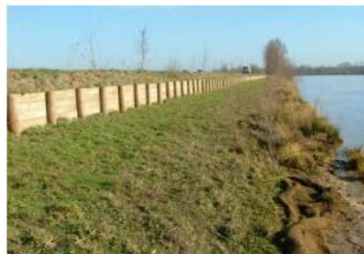
Figure 6.6. Protection par risberme d'hélrophytes sur la Saône. Le tunage dans ce cas ne sert qu'à gagner de la hauteur de berge (photo CETE Lyon.) (ONEMA, 2008)
