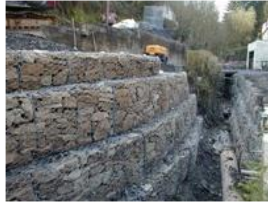
Stabilisation par matelas gabions
