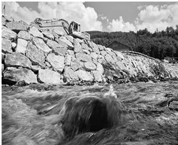
Stabilisation par enrochement
