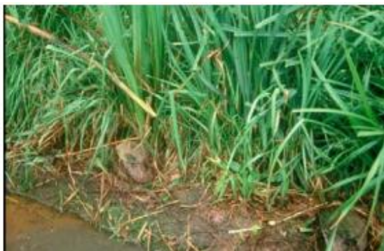
Figure 6.5. Fascine d'hélrophytes sur lys (photo Biotec.) (ONEMA, 2008)
