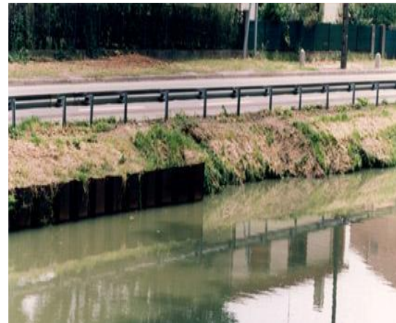
Stabilisation par palplanches
