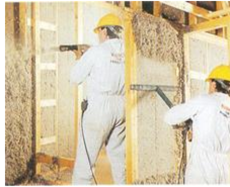
Flocons de cellulose humidifiées et projetés.
