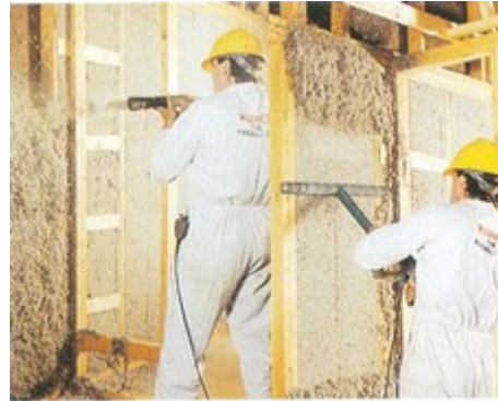
Flocons de cellulose humidifiées et projetés.
